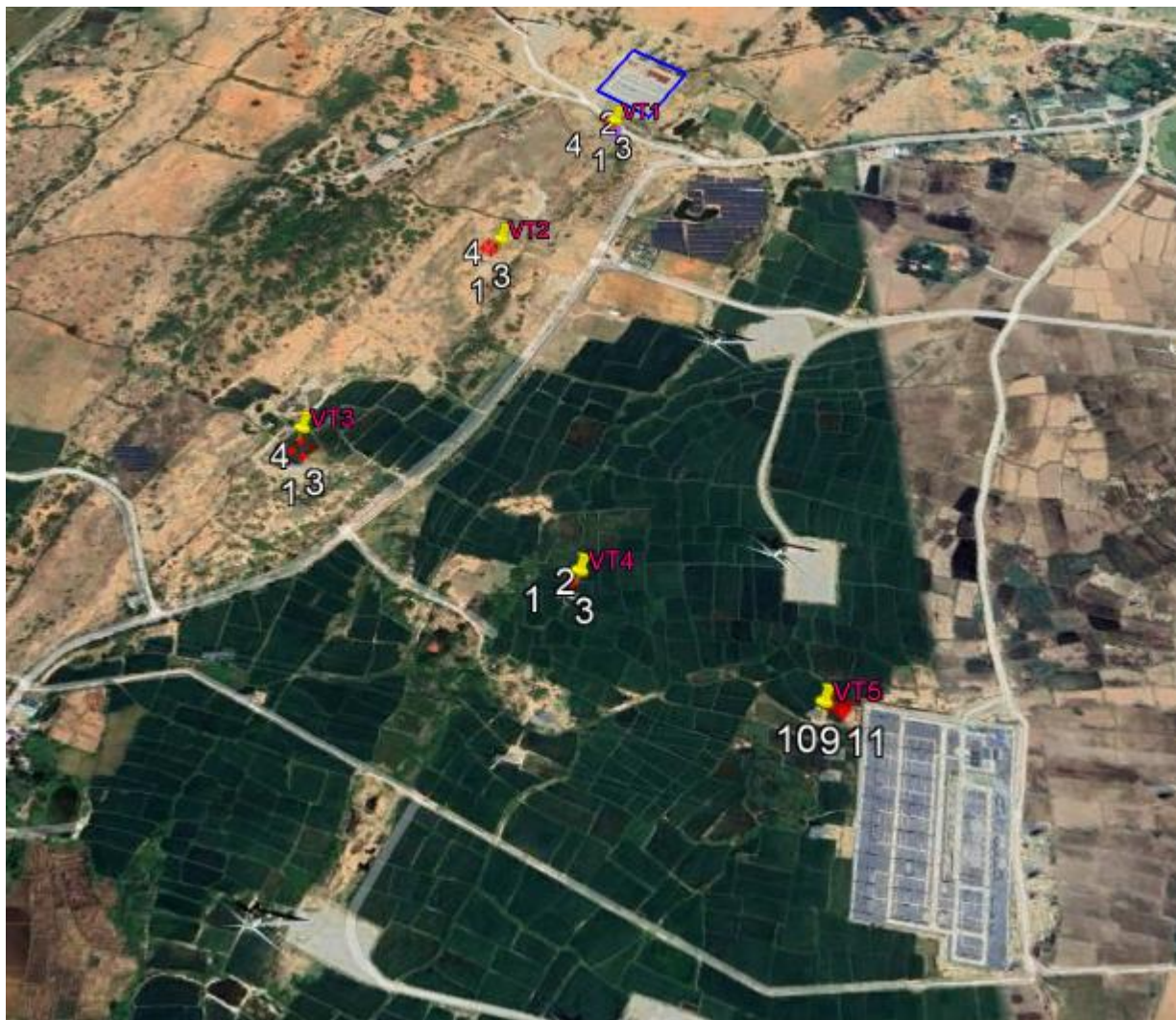
Hình: Vị trí các cột điện của đường dây đầu nối
