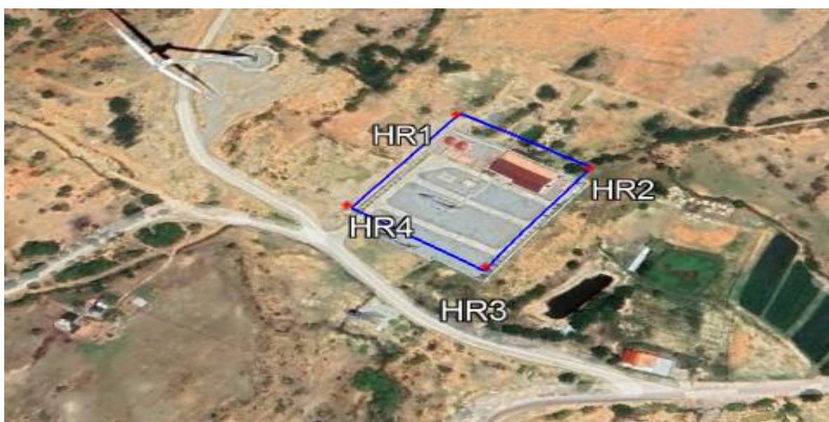
Hình 2. Hình ảnh khu vực trạm biến áp và nhà điều khiển
